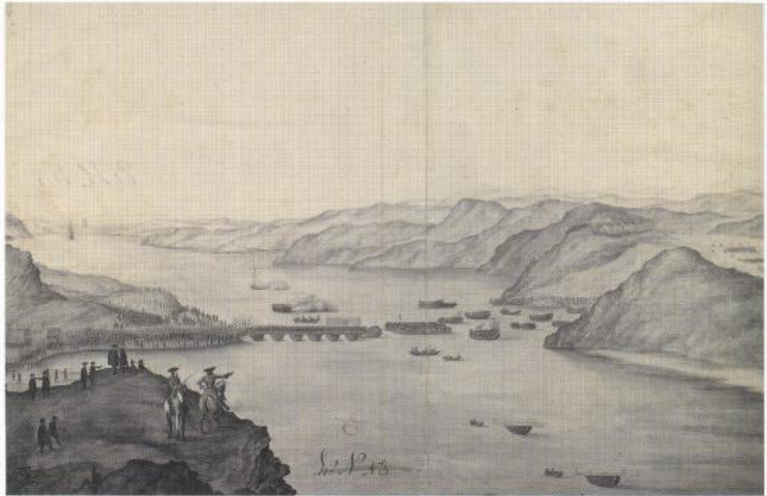
Utsikt mot väster över Svinesund. Generalen C. G. Dücker låter bygga en pontonbro över Svinesund vid Sundsborg den 9 november 1718. Notera hur prefabricerade brodelar bogseras fram till bygget. Pennteckning i tusch av okänd tecknare. KrA.
