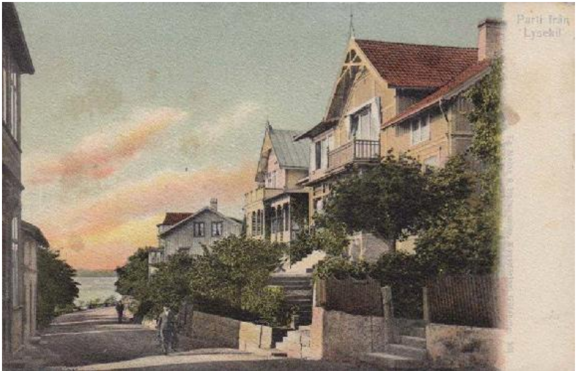
1903 cirka På fotografiet ses närmast till höger huset på Rosviksgatan 16. Huset är uppfört av författaren Ulrika Mathilda Henrietta Lundström, född Tengbom, kallad Mattis. Närmast därefter ses professor Anders Wides hus på Rosviksgatan 18.
